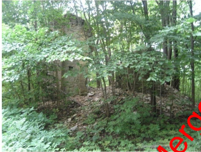
Kabeli varemed põhjast vaadatuna 2008.a
