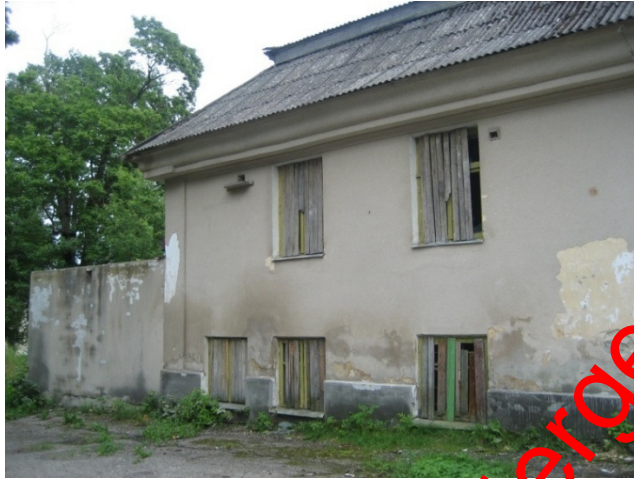
Vaade härrastemaja põhjapoolsele tiivale 2008.a. (näna on soklikorrukse aknad ja selle peal asuva tõsteuid esimese korruse aknad)
