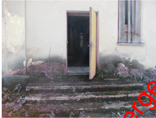
Läänefassaadi sissepääs, mis viib eelmisel fotol olevasse trepikotta. (tulevane peasissepääs kogukonnakesksetele teenustele, mis paiknevad ärklikorrusel)
