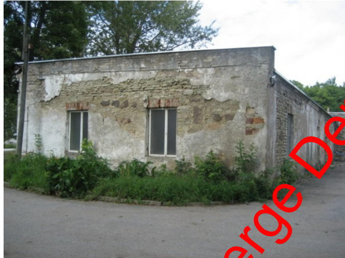
Vaade endise majanduskastelli läänetiivale 2008.a
